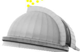
屋上・天体観測ドーム
